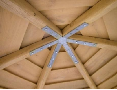
Gepotdekseld dak met houten onderconstructie De steelverbinding zorgt voor blijvende stabiliteit
